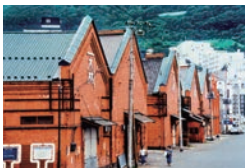
商業施設として改修する前の倉庫
