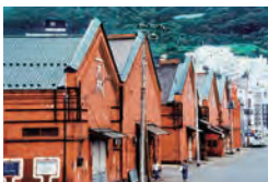
商業施設として改修する前の倉庫
