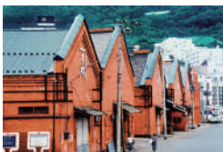
商業施設として改修する前の倉庫
